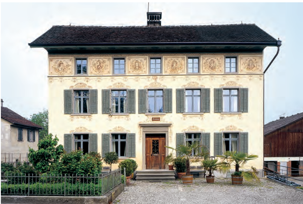
Gesamtansicht der Hauptfassade. Zustand nach der Restaurierung, 2005. Fotoarchiv HBA.
