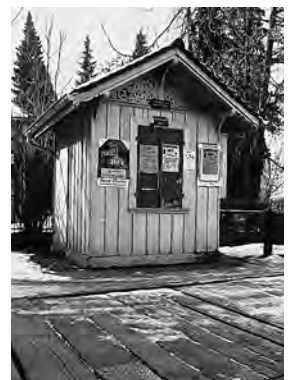
Das Brückenwaage-Häuschen vor der Renovation. Zustand 1993.
