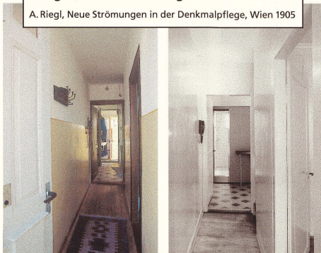
Haus Nr. 27 Korridor
