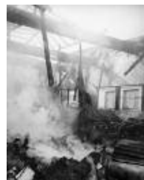
Lagerhalle nach dem Brand vom 12. Oktober 1970. StadtBW.
