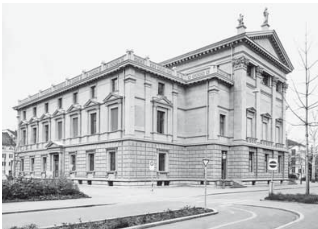
Das Stadthaus von Nord-osten. Zustand nach der Restaurierung, April 2010. KDP Fotoarchiv.
