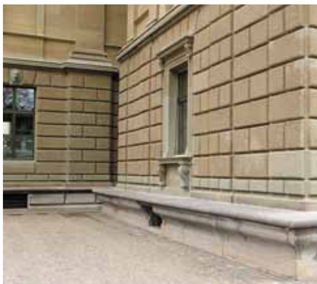
Links: Westliches Portal. Zustand nach der Restaurierung, April 2010. Rechts: Sockelzone. Zustand nach der Restaurierung, April 2010. KDP Fotoarchiv.
