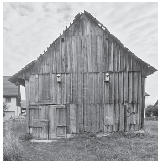
Links und rechts: Ansicht der Süd-, bzw. der Nordfassade. Zustand vor der Instandstellung, Juli 2002. KDP Fotoarchiv.
