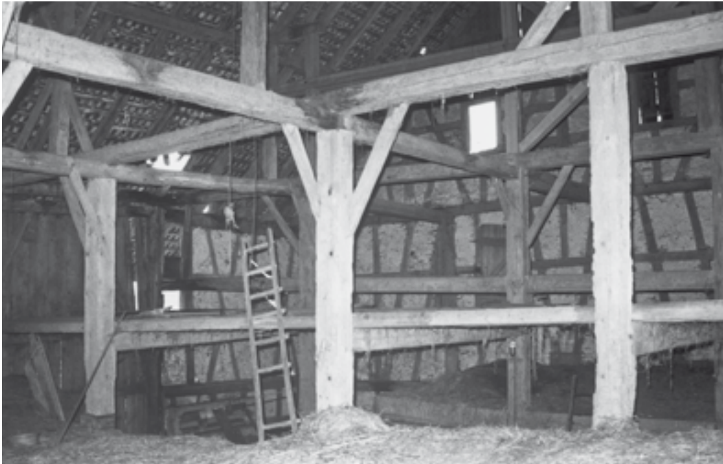
Blick in die Scheune von Südwesten. Zustand 1986. KDP Fotoarchiv.
