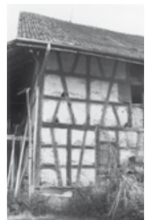
Ausschnitt aus der Nordfassade des Ökonomieteils, Zustand 1986. KDP Fotoarchiv.
