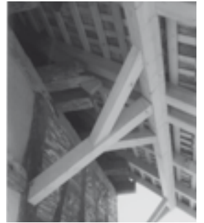
Dachuntersicht sowie Vordachstütze mit Flugpfette an der giebelseitigen Erweiterung von 1807. Zustand nach der Instandstellung, November 2004. KDP Fotoarchiv.
