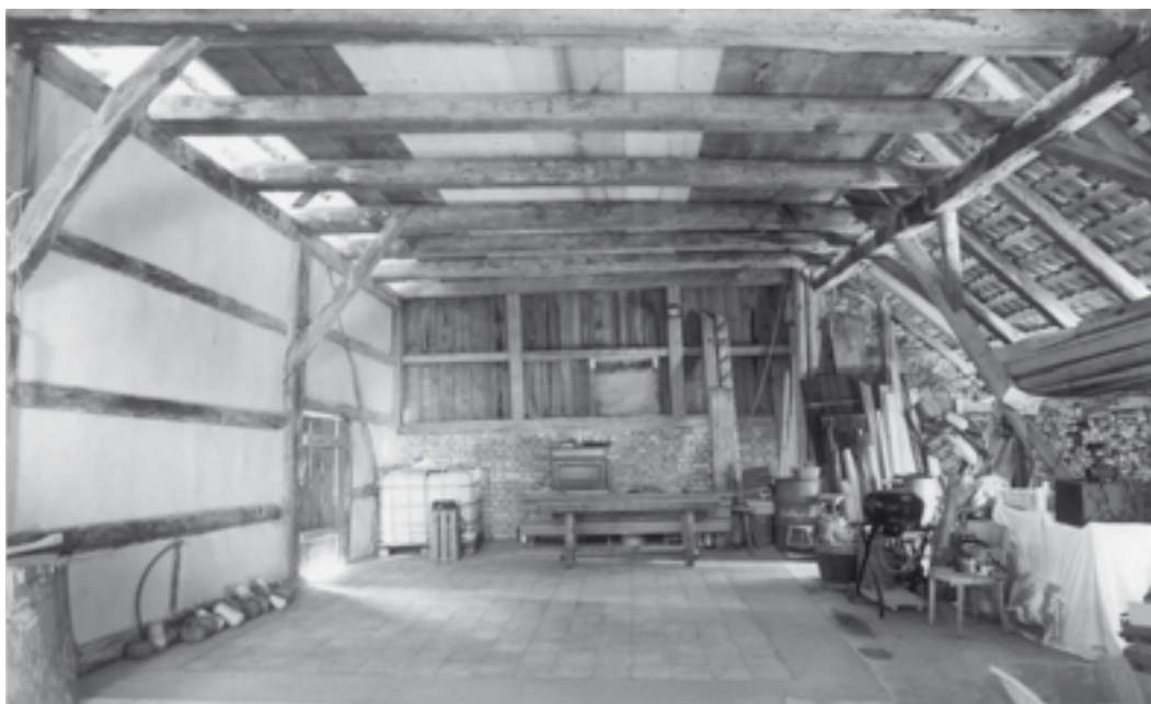
Ehem. Trottraum im Erdgeschoss. Links Fachwerkwand des Kernbaus, rechts traufseitige Erweiterung von 1807. Zustand nach der Instandstellung, November 2004. KDP Fotoarchiv.
