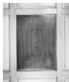
Oben: Ausschnitt des originalen Deckentäfers mit Einlegearbeit in der Stube. Zustand vor der Restaurierung, Juni 2003. Unten: Teilansicht des Wein- und Obstkellers. Zustand Juni 2003. KDP Fotoarchiv.
