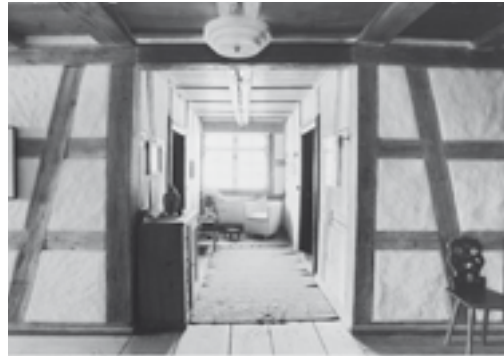
Links: Feuerwand mit altem Sparherd in der Küche im Erdgeschoss. Zustand nach der Renovation, März 2004. Rechts: Westlicher Teil des kreuzförmigen Korridors im Obergeschoss. Zustand nach der Renovation, März 2004. KDP Fotoarchiv.
