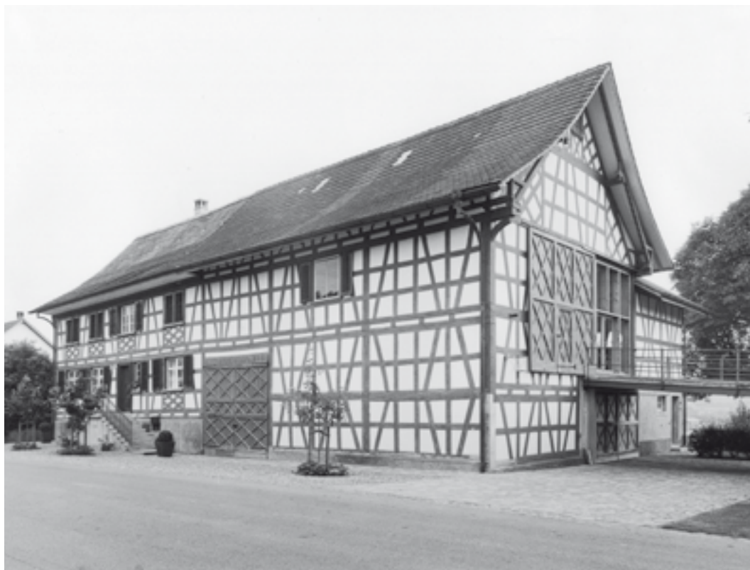
Gesamtansicht von Nord- osten. Zustand nach der Renovation, Juni 2005. KDP Fotoarchiv.
