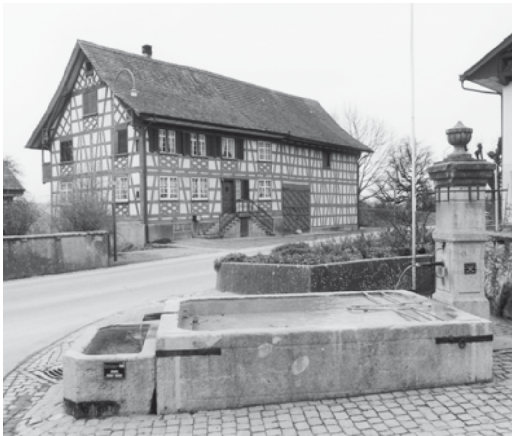
Gesamtansicht von Süd- osten. Zustand vor der Renovation, März 1996. KDP Fotoarchiv.
