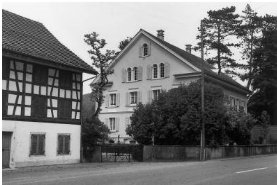
Ansicht von Südwesten mit dem Gartentor von 1937 und dem Ökonomiegebäude Vers. Nr. 65. Zustand nach der Fassadenrenovation, Juni 2008. KDP Fotoarchiv.
