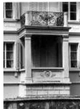
Ehemaliger Portikus an der Südfassade. Zustand nach der Fassadenrenovation, Juni 2008. KDP Fotoarchiv.
