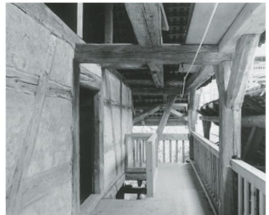
Links: Ansicht der nachträglich im Obergeschoss der ehemaligen Stallscheune eingebauten Kammer mit neuer Vertäferung aus wiederverwendeten Zimmertüren. Zustand nach der Renovation, November 1999.
