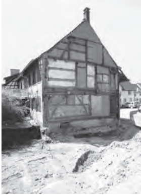
Ansicht der nordöstlichen Giebelfassade von 1526d nach dem Abbruch des nachträglich hinzugefügten Ökonomieteils. Zustand April 2000. Fotoarchiv HBA.
