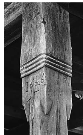
Zentrale Eichenstütze im Trottkeller mit der Jahrzahl 1626, Zustand 2000.
