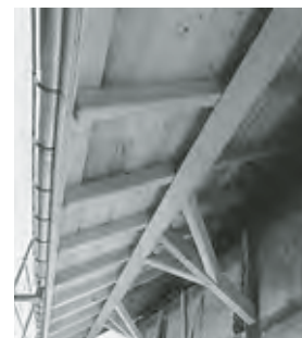
Neues, strebengestütztes Vordach auf der östlichen Traufseite. Zustand Juli 1997. Fotoarchiv HBA.
