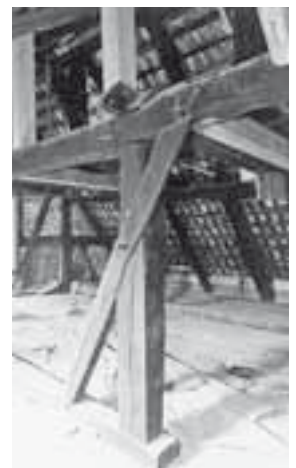
Dachraum 2.1. Stuhlsäule der Dachkonstruktion, 1463d. Zustand vor der Restaurierung, August 2004. KDP Fotoarchiv.
