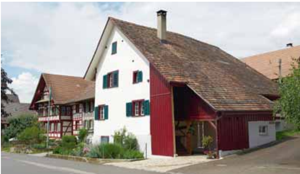
Gesamtansicht von Süden. Zustand nach der Restaurierung, Juni 2011. KDP Fotoarchiv.
