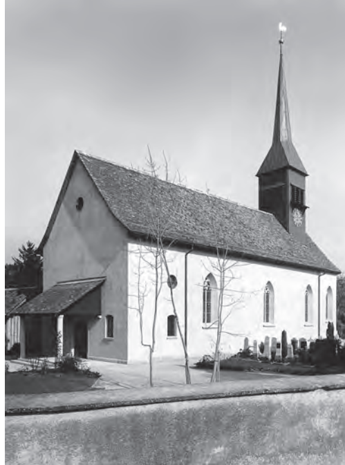
Links und rechts: Gesamtansichten von Südwesten vor bzw. nach der durchgreifenden Gesamtrenovation 1947–1948. Zustand Juni 1947 bzw. Oktober 1948. Aufnahmen von Kantonsfotograf Max Weiss (1912–2003), Fotoarchiv HBA.
