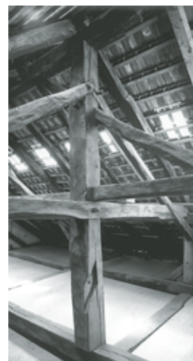
Ansicht der originalen Dachkonstruktion über dem Wohnhausteil. Einzelne Glasziegel lassen Tageslicht in den Dachraum dringen. Zustand September 1997. Fotoarchiv HBA.
